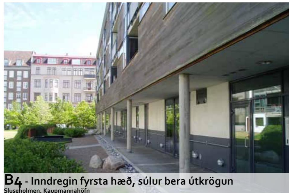
B1 - Inndregin fyrsta hæð, súlur bera útkrögun Sluseholmen, Kaupmannahöfn
