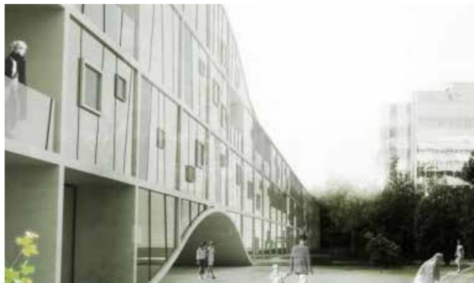
C4 - Port gegnum byggingu, tengir útirými saman
