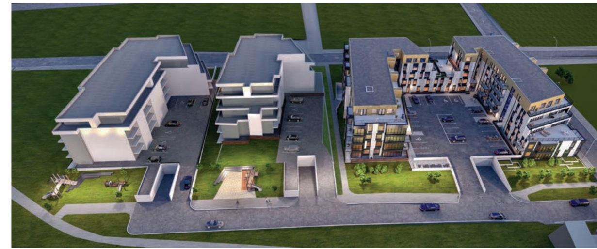
Skýringarmynd A: Form og massastúdia - ekki endanlegt útlit. Horft á uppbyggingu úr norðri.
