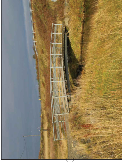
TIL VIÐMIÐUNAR REIÐBRÚ YFIR HÓLMÓSA, NEDAN F. JÁRÞORÐGAR. STÆRÐ Á REIÐBRÚ, BREIÐD 2.60 m, LENGD 11.0 m
