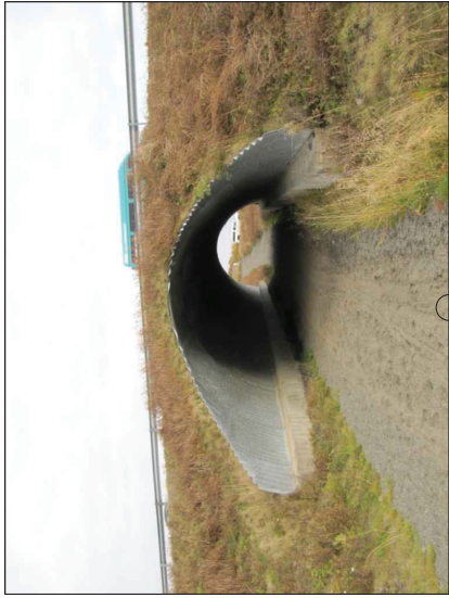
TIL VIÐMIÐUNAR REIÐGÖNG UNDR SUÐURLANDSVEIG NEDAN F. JÁRÞORÐGAR. STÆRÐ Á REIÐGÖNGUM HEIÐ 5.8 m, hæð 4.3 m SANKVÆMT REIÐVEGABÓK VIR OG LI SKAL RÝMI Í REIÐGÖNGUM VEFA MINNST BREIÐD 3.0 m OG HÆÐ 3.0 m.
